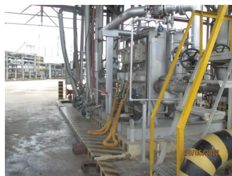
รูปที่ 52 Grounding บริเวณ Loading Rack
