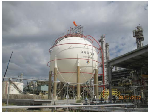
รูปที่ 66 ระบบฉีดพรมน้ำบริเวณถังเก็บ
