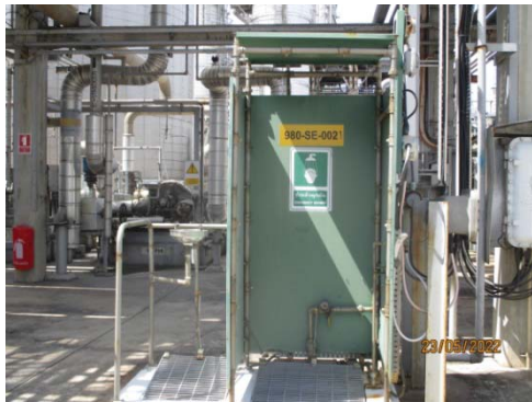
รูปที่ 38 อุปกรณ์ชำระล้างฉุกเฉิน
