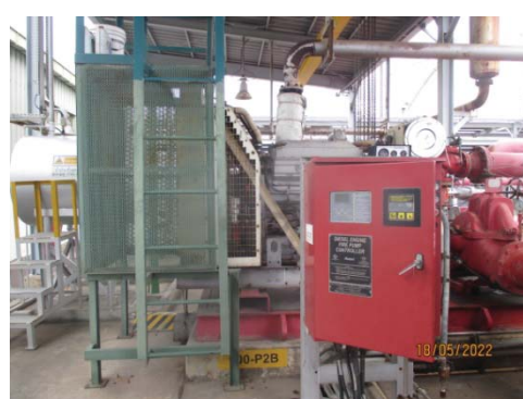
รูปที่ 60 ปั๊มน้ำดับเพลิง แบบ Diesel Pump
