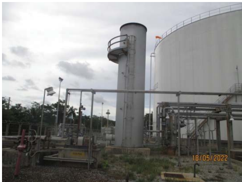
รูปที่ 1 ระบบกำจัดไอสารไฮโดรคาร์บอน (Vapor Disposal System)
