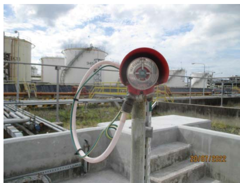
รูปที่ 49 Gas Detector บริเวณถังเก็บสำรอง
