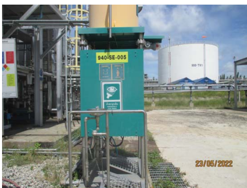
รูปที่ 40 Eye Washer บริเวณ UF&RO Units
