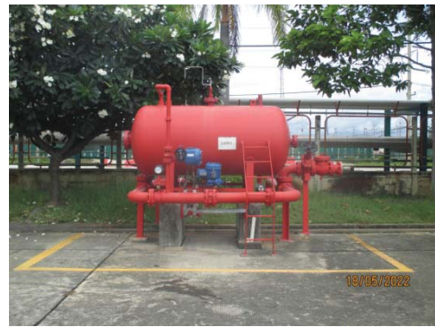
รูปที่ 54 ระบบโฟมดับเพลิง
