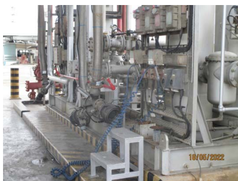
รูปที่ 51 Vapor Return Arm บริเวณ Loading Rack
