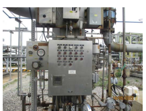
รูปที่ 47 หน้าจอควบคุมระบบการเผาไหม้ สารไฮโดรคาร์บอน
