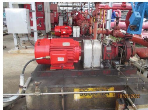
รูปที่ 65 ปั้มน้ำดับเพลิงแบบไฟฟ้า
