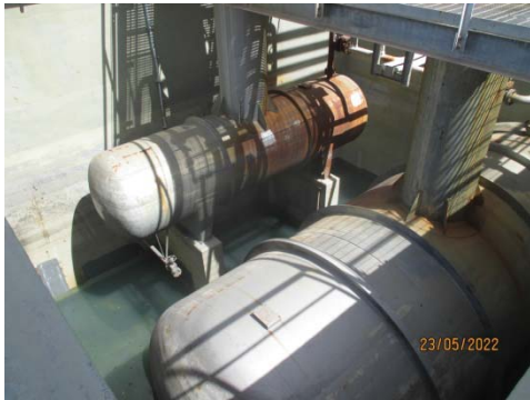
รูปที่ 7 Close Aromatics Drain (CAD)
