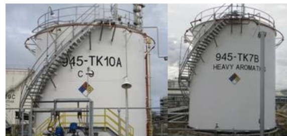
รูปที่ 4 ถังเก็บสำรองไฮโดรคาร์บอน ชนิด IRFN และชนิด CRN
