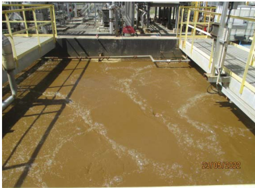
รูปที่ 19 Aeration Tank
