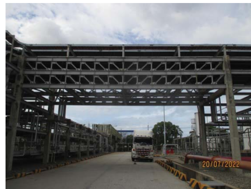
รูปที่ 67 ท่อรับส่งวัตถุดิบ-ผลิตภัณฑ์วางตัวบน Pipe Rack และ Pipe Bride
