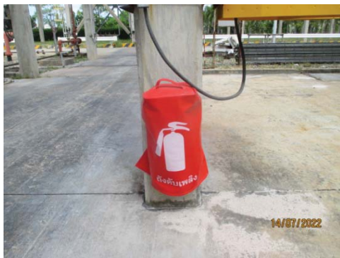
รูปที่ 58 เครื่องดับเพลิงชนิดผงเคมีแห้ง
