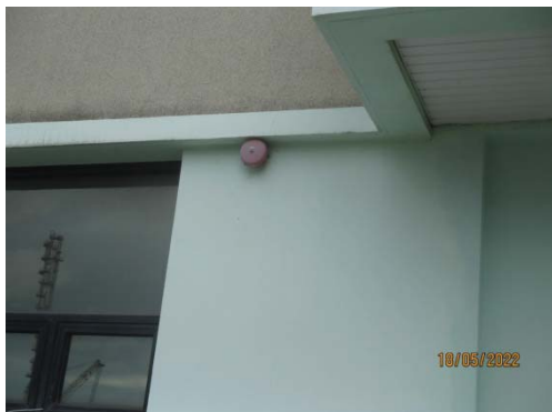
รูปที่ 64 กระดิ่งสัญญาณเตือนภัย
