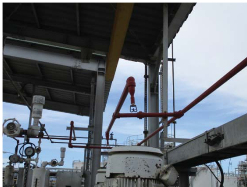
รูปที่ 63 ระบบ Sprinkler
