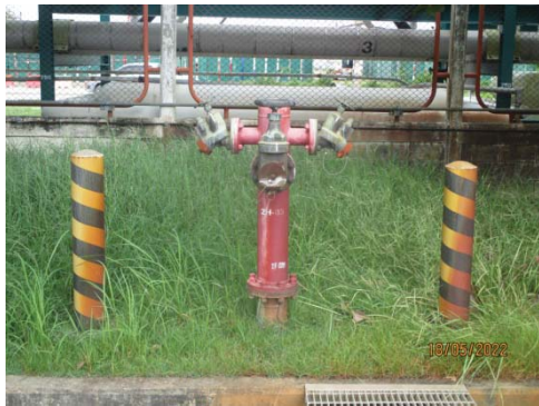
รูปที่ 57 Water Hydrant
