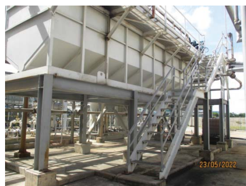
รูปที่ 18 Dissolved Air Floatation (DAF)
