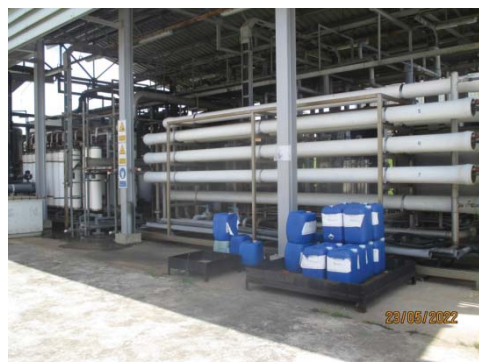
รูปที่ 29 ระบบ UF&RO
