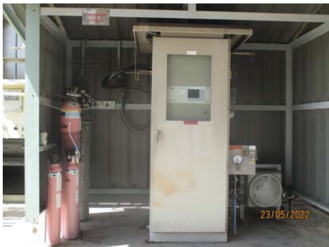
รูปที่ 3 อุปกรณ์การตรวจวัดการระบาย มลสารจากปล่องอัตโนมัติ (CEMs)
