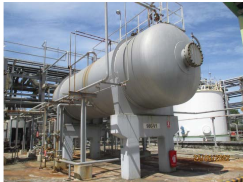
รูปที่ 12 ระบบ Neutralization Drum (980-V1)
