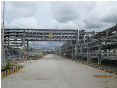
รูปที่ 67 ท่อรับส่งวัตถุดิบ-ผลิตภัณฑ์วางตัวบน Pipe Rack และ Pipe Bride
